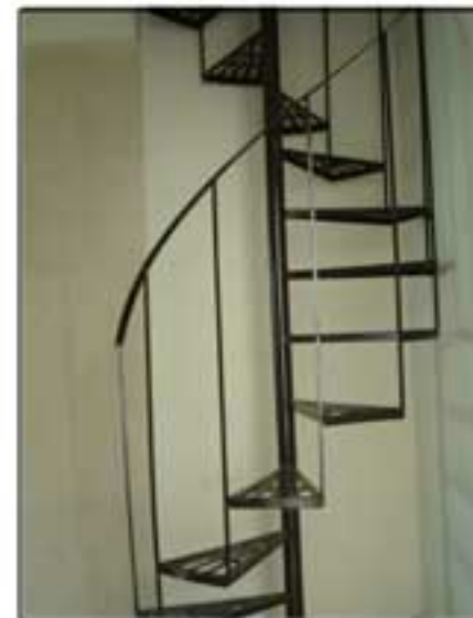
Escalera de servicio
