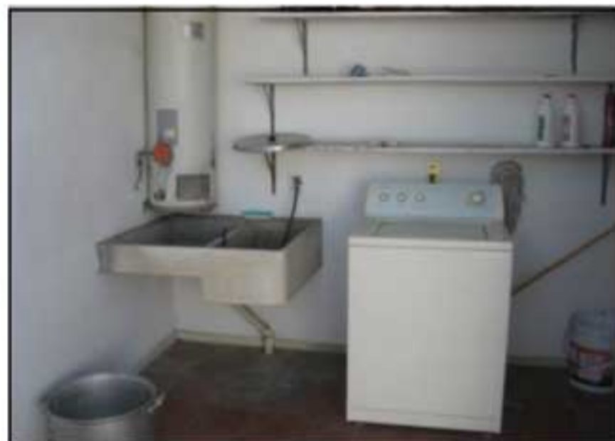
Cuarto de lavado
